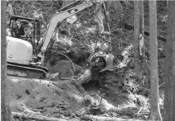
写真① ザウルスによる作業道の作設
