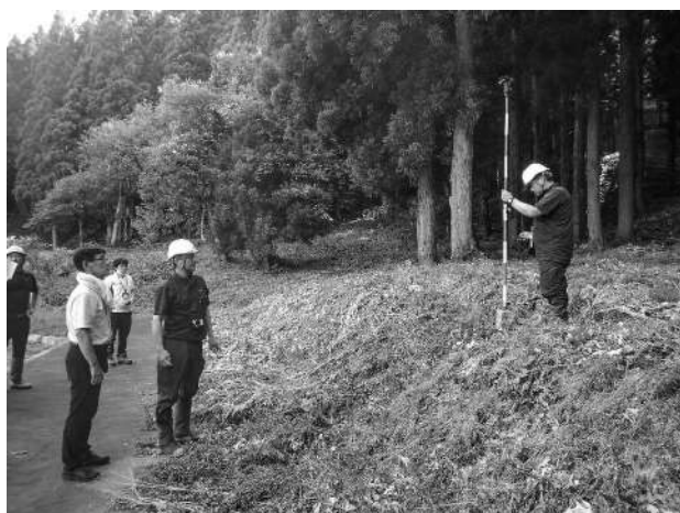
【RTK-GNSS測位法による境界明確化作業】
