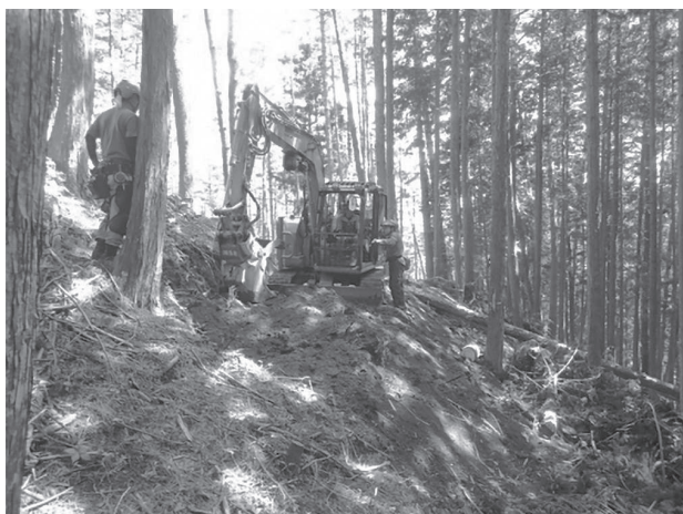
写真3 現地指導 作業道作設実施状況
