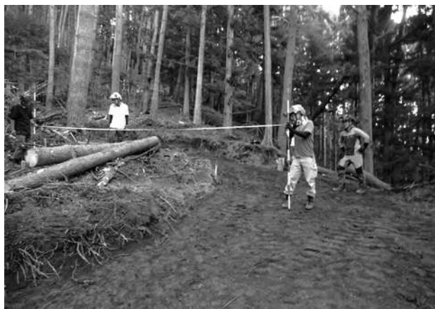
写真4 ヘアピンカーブ仕上がり状況の確認
