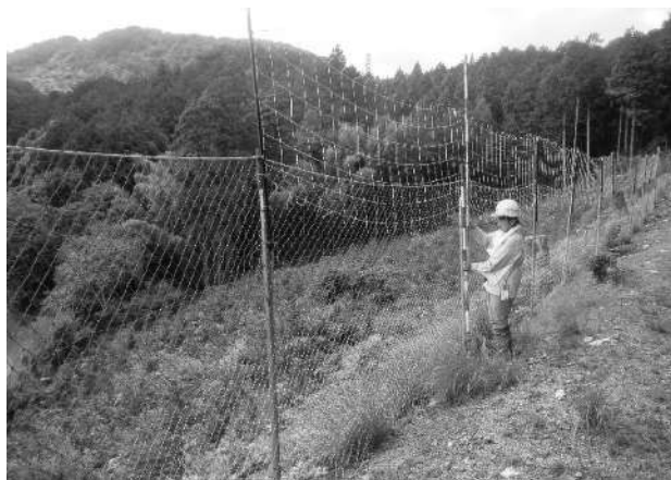
獣害柵を延長し跳び越え防止の強化
