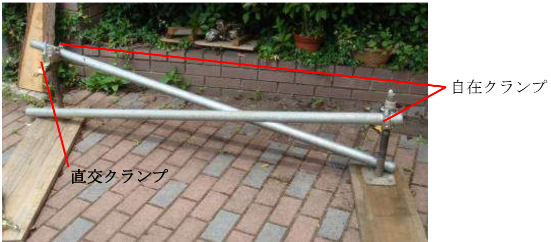
図 10 初めに足場パイプを自在クランプに固定
